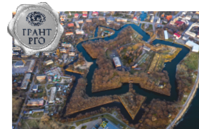
Все постройки цитадели Балтийска охвачены VR-туром. Фото: Центр современной истории
